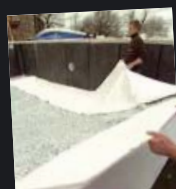
Pose du liner
