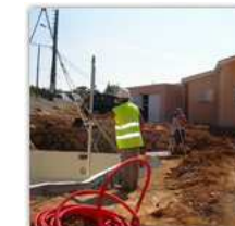
Contrôle des niveaux de la piscine posée
