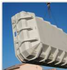
Livraison de la piscine coque polyester (grutage)
