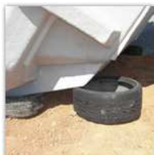
Préparation du grutage de la piscine
