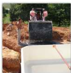
Soutien dans les étapes de remblaiement
