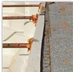
Mise en oeuvre de la ceinture béton
